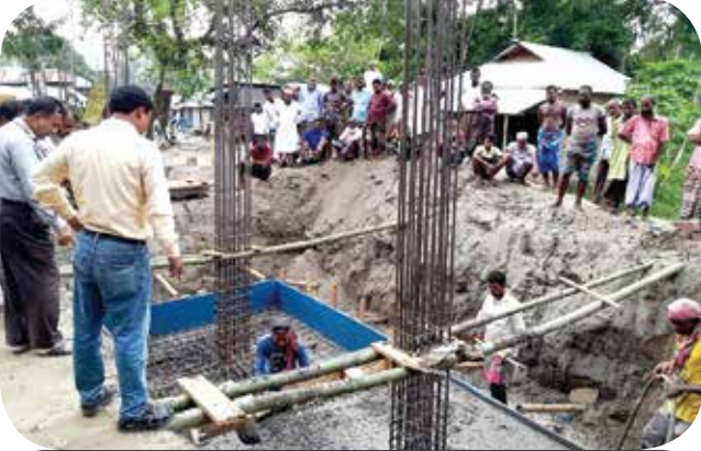
কাটাঝাড়িরডাংগা সরকারি প্রাথমিক বিদ্যালয়, তারাগঞ্জ, রংপুর-এর বেজ ঢালাই। নাগরিক দলের সদস্যগণ শুরু থেকে শেষ ঢালাই কাজের সঙ্গে থাকেন।
