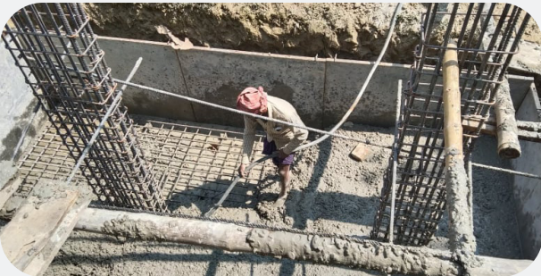
সিরাজগঞ্জের বেলকুটিতে সালদাইড ক্ষিদ্রগোপরেখী সরকারী প্রাথমিক বিদ্যালয়ের বেজ ঢালাইয়ের কাজ পরিদর্শন।
